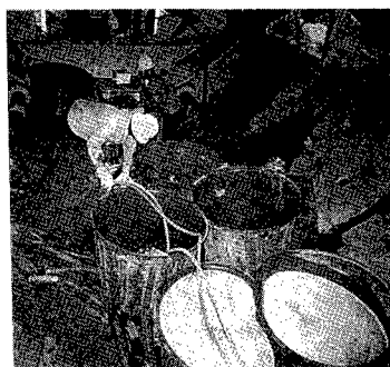
写真－4 充填材注入状況（実機）
