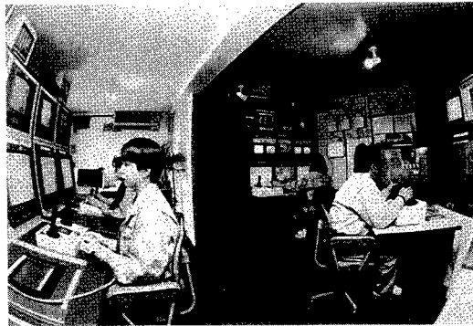
コントロールルームの操作状況
