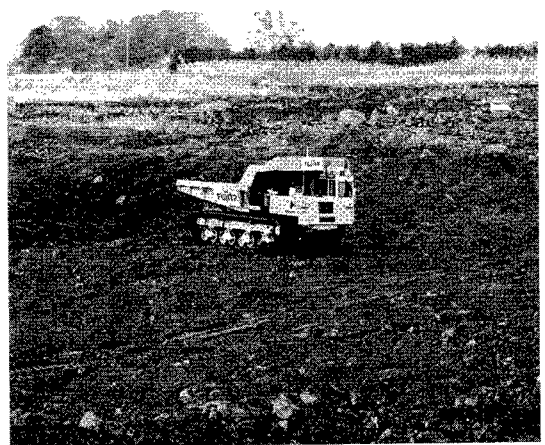
写真-1 無人測量状況
