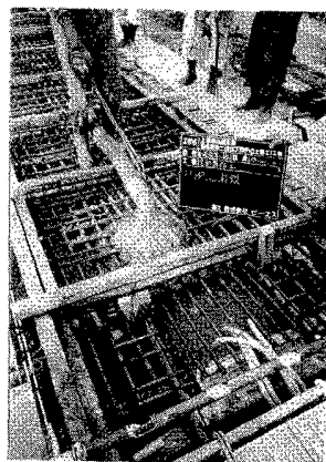
写真-1 打込み状況
