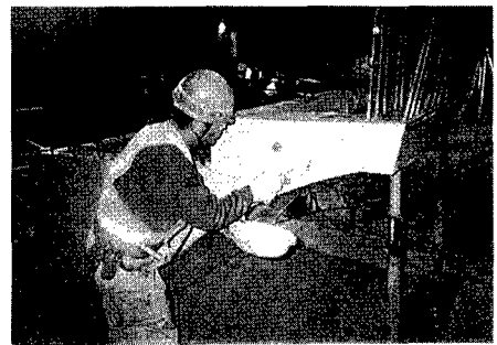
写真－1 コンクリートボンド塗布及び接合キー
