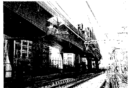
写真－2 プレキャスト部材架設後の状況
