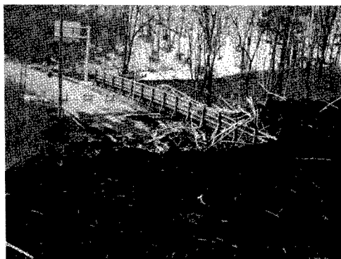
図-3 火山礫・雪・樹木で埋まったスカイライン
