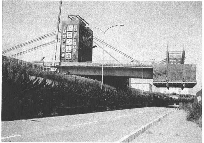
写真-1 施工現場遠景
