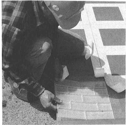
写真-1 シートの張付け状況
