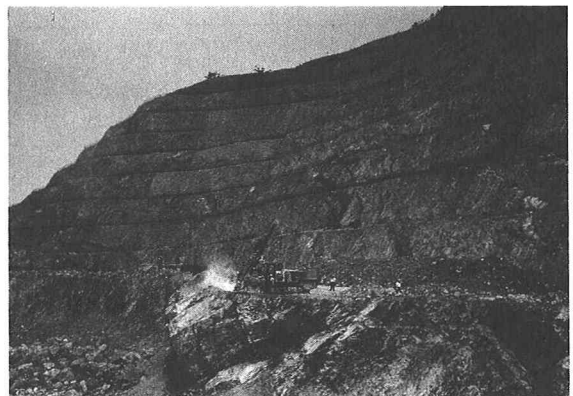
写真－3 鉾山残壁での削孔試験状況
