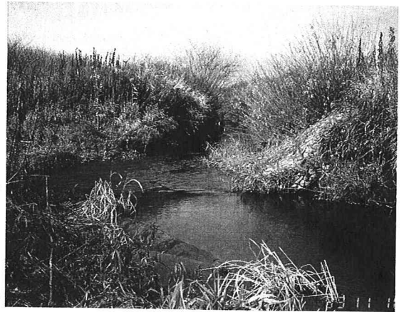
写真 帯工部分
