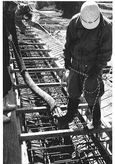
写真-1 打ち込み
