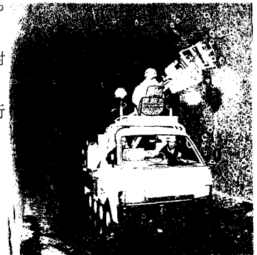
図-4 トンネル縦断測定状況
