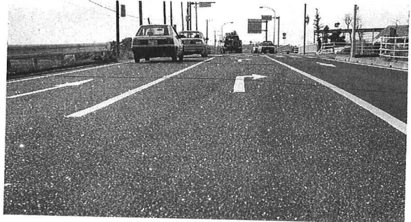
写真-1 路面状況
