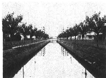
写真 1 橋上視点において 評価の高かった 植樹1.0m間隔 (河川幅1.5m)
