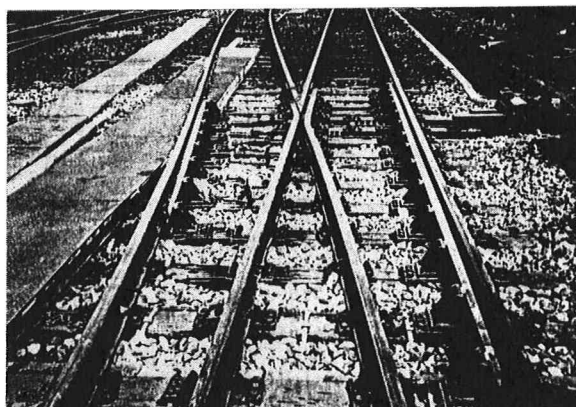
図-1 ウィング可動クロッシング
