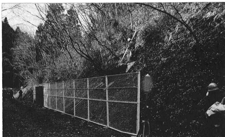
写真 センサーケーブル方式による現場試験
