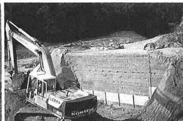
写真－5 鉛直自立壁の完成
