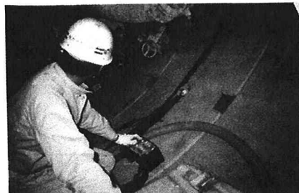
写真-3 コッター締結状況
