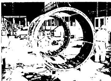
写真-2 解体後の状況
