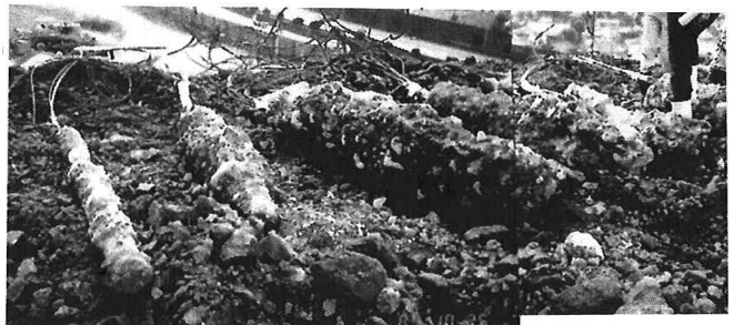
写真-1 アンカー体掘りだし調査
