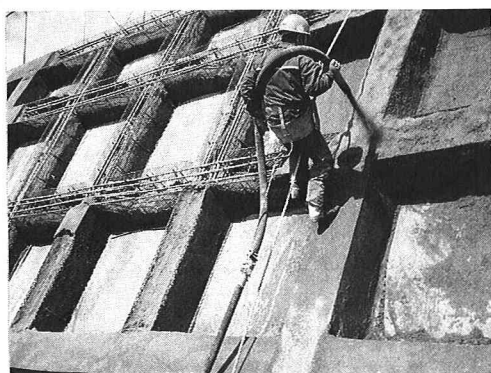
写真-3 コンクリート吹付け状況
