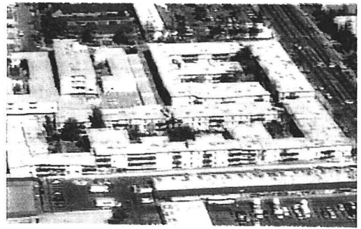
図3 メドゥズアパートメント（左下が被害甚大） 4)
