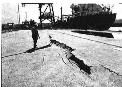
図7 商業港の液状化地盤に開いた亀裂
