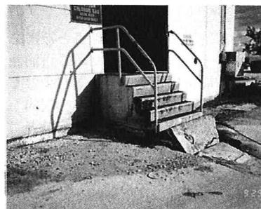
図6 海軍発電所における液状化後の地盤沈下
