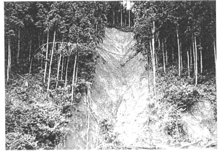
写真-1 岐阜県岩村町での崩壊事例
