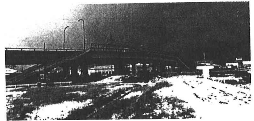
写真-1 有田跨線橋全景
