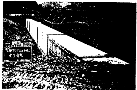
写真-1 水路トンネル施工完了状況
