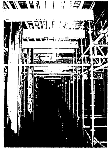
写真-1 システム支保工
