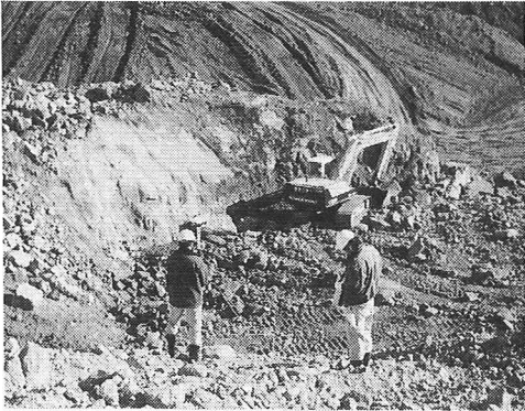
写真-2 現場状況（3ヶ月後）
