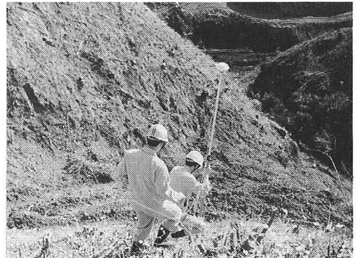
写真-1 現場現況(原地盤)
