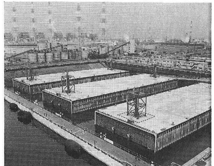
写真－1 施工状況
