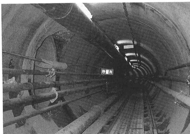
写真-1 流入管取付部状況
