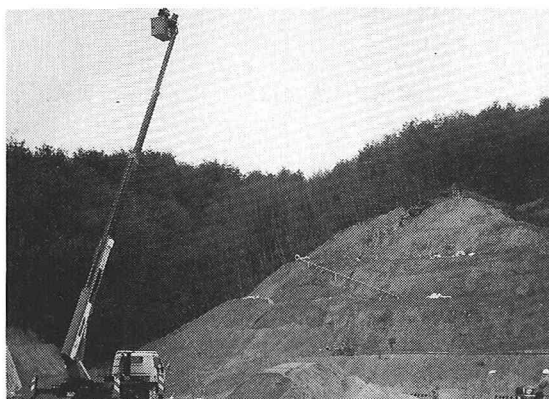
写真-3 法面測量への適用状況
