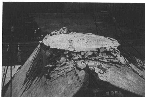
写真一1 スラブの破壊状況（落下高さ 5.0 m）
