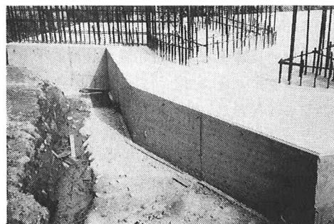
写真-1 基礎コンクリートの出来型
