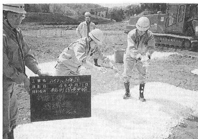
写真-1 短繊維散布状況
