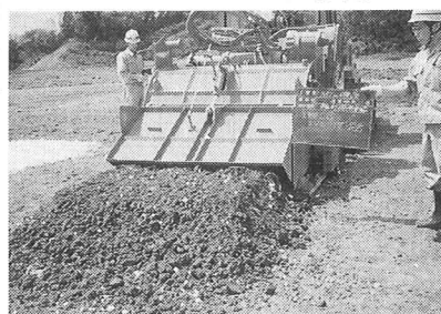
写真-2 スタビライザー混合状況
