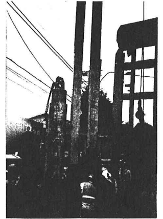
写真-1 芯材建込み状況
