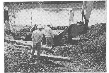
写真-1 不攪乱法による供試体採取状況
