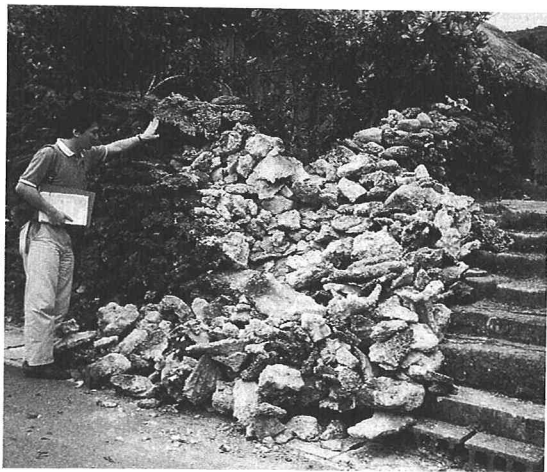
写真1 石化した珊瑚の石垣の崩壊
