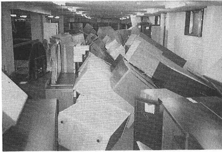
写真1 釧路沖地震(1993年1月15日)による家具の転倒被害 (釧路市M家具店)
