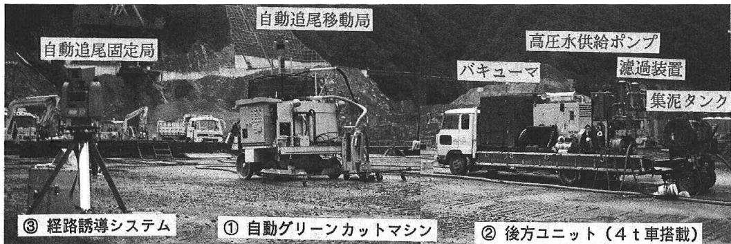
写真-1 自動グリーンカットシステム
