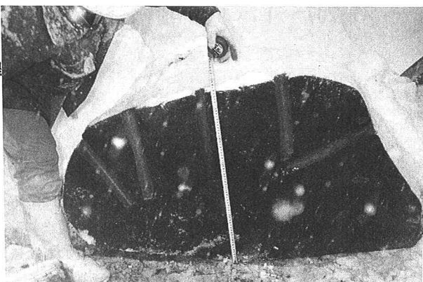
写真-2 砂岩の転石の破砕状況 (③)
