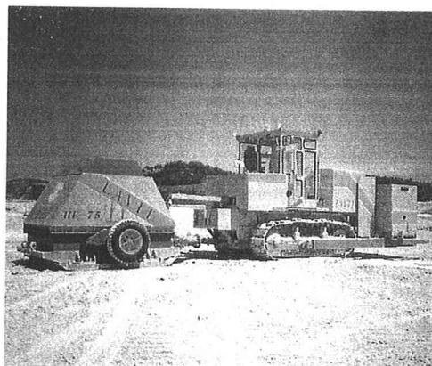
写真-1 牽引式MVT施工機
