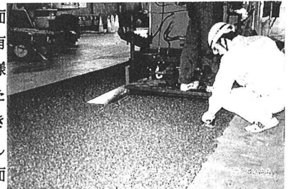
写真－２ 試験施工状況
