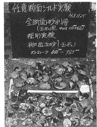
写真-2 排出玉石状況
