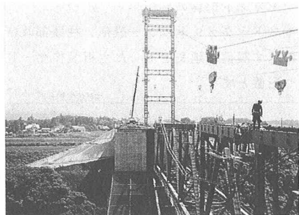
写-2 ケーブルクレーン架設
