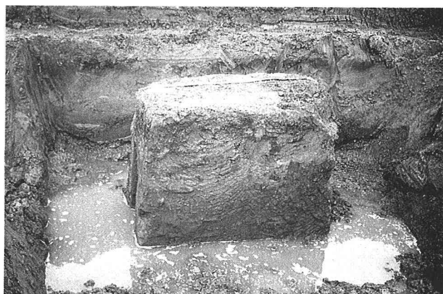
写真-1 掘り出した改良体
