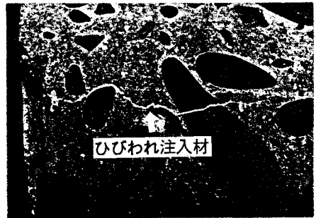
図2 劣化抑制型注入材の注入状態
