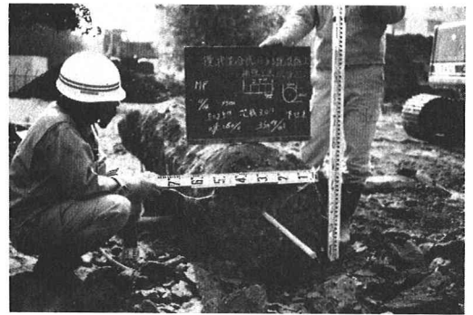
写真1 掘り出した攪拌混合補強体
