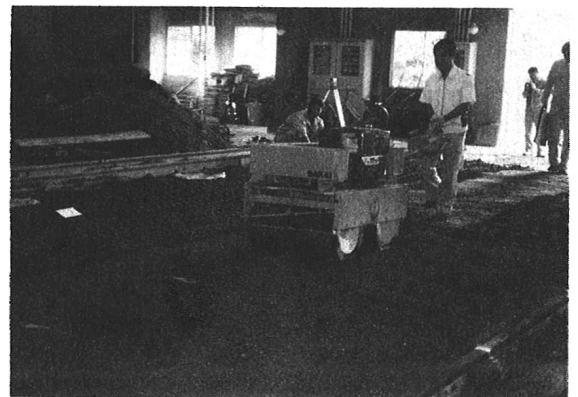
写真-1 小型ローラーによる転圧状況
