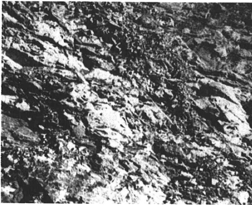
図-4 岩盤分類を実施した原画像
