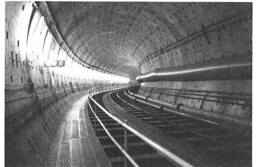
図-4 セグメント組立状況
